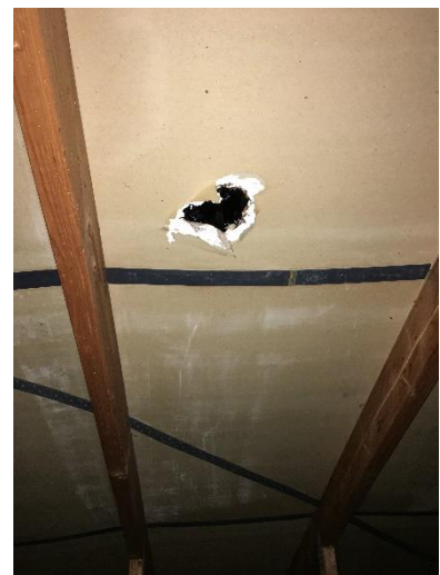
Undertag i gipsbaseret plademateriale – her med skade/gennembrydning.
