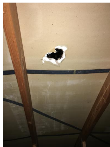
Undertag i gipsbaseret plademateriale – formodentlig Gyproc – her med skade.
