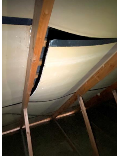
Undertag i gipsbaseret plademateriale – undertag ses at hænge mellem spær, og klæbning med tape har en skade
