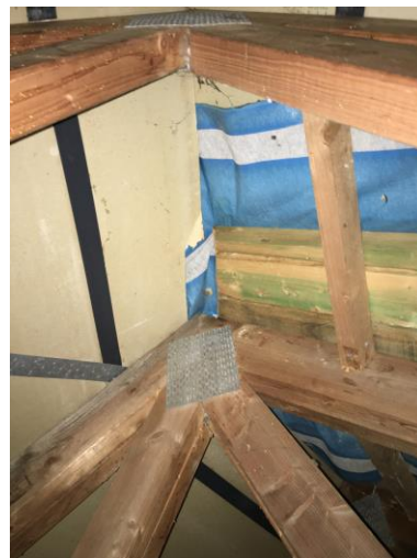
Flere steder ses den underliggende tagkonstruktion ukorrekt udført.
