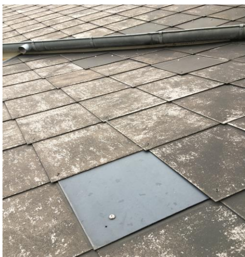
Tagplader er enkelte steder udskiftet, hvilket vidner om at tagbelægningerne er nedslidte og udskiftningsparate.
